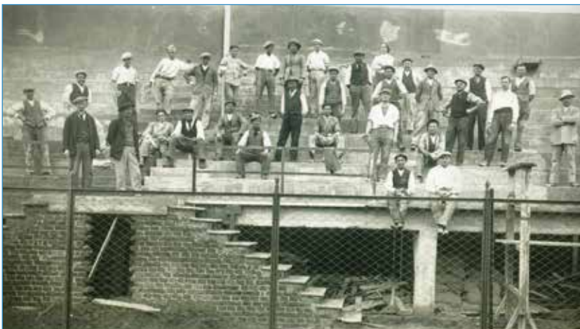
Le maestranze impegnate nella costruzione dello stadio di Via Alcarotti
